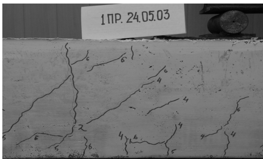
Рис. Трещинообразование фибропеножелезобетонной перемычки при испытаниях на несущую способность
